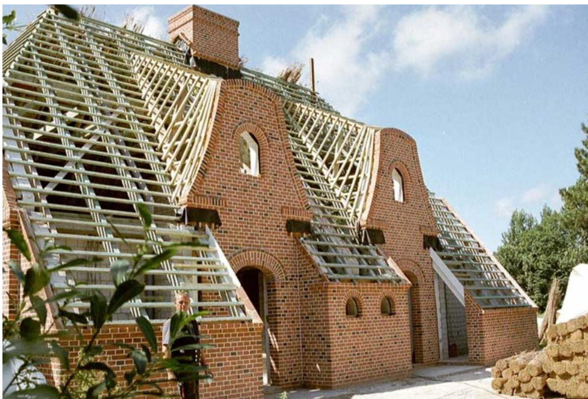
3. ábra: Nádfedeles ház tetőszerkezete
